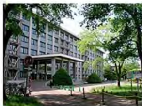
6 工学部本館玄関
