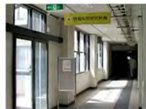
8 工学部本館1F通路
